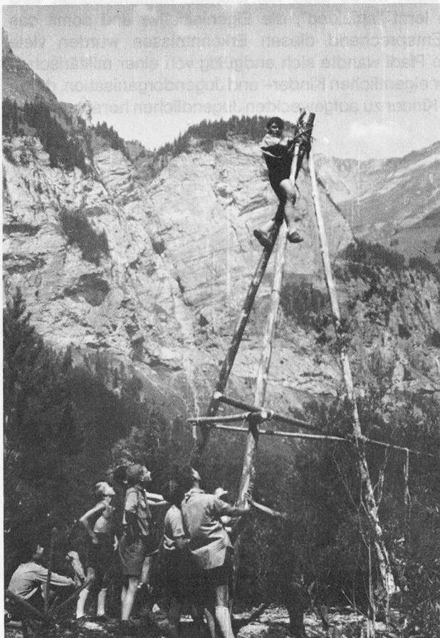
Bau des Lagerturms
